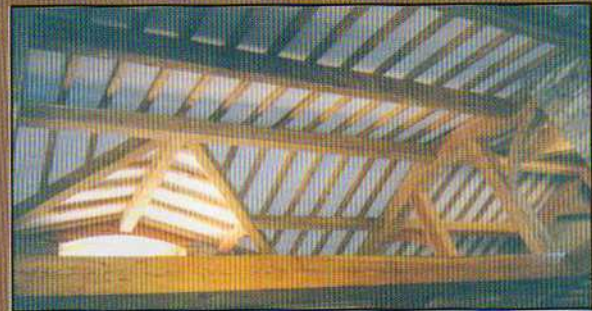
Rénovation d'une maison ancienne, avec chien assis en sapin Douglas.
