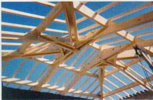
Réalisation d'un 4 pentes à entrains rentraissés moisés
