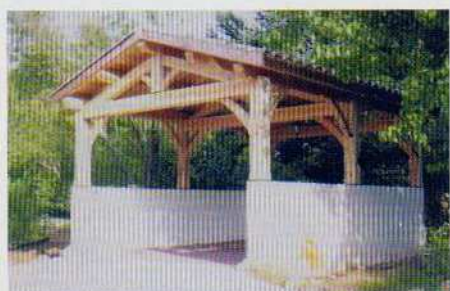
Réalisation d'un abri voiture composé de 3 fermes en sapin Douglas
